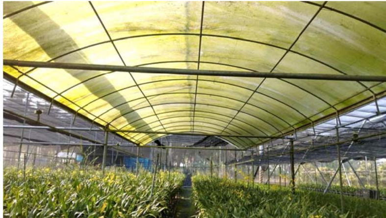
圖2. 網室內搭建之塑膠布防雨棚在試驗後期青苔著生嚴重
