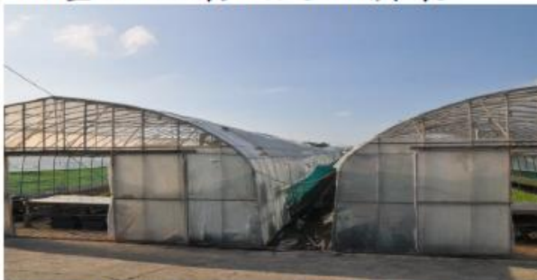
結構較強健但因風力強大而損壞設施
