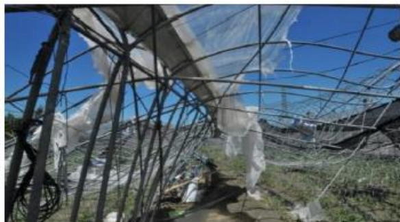
結構連接件與補強設計不佳
