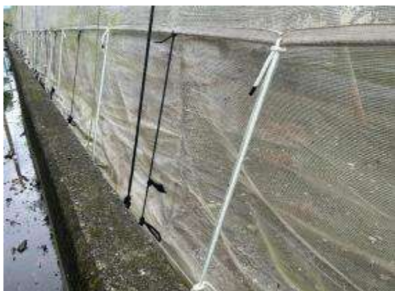
網室設施應加強固定，避免瞬間強風毀損防蟲網。
