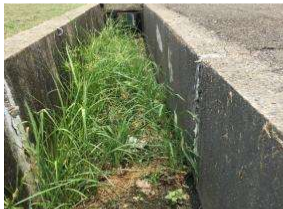
園區排水溝確保順暢，即時清除雜草、殘枝或落果，避免阻塞排水。
