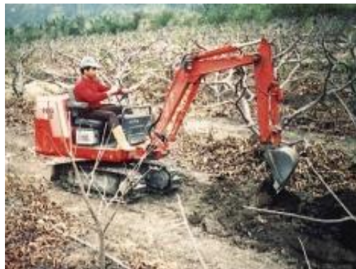
圖 2 利用小型挖土機進行開溝作業
