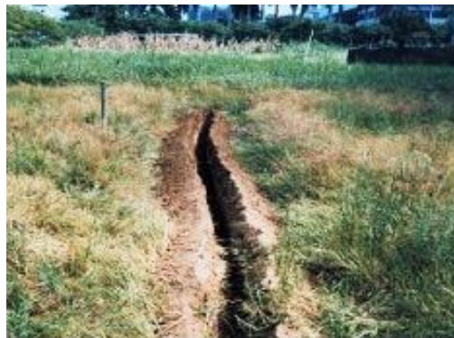
圖 4 直線開溝後的情況
