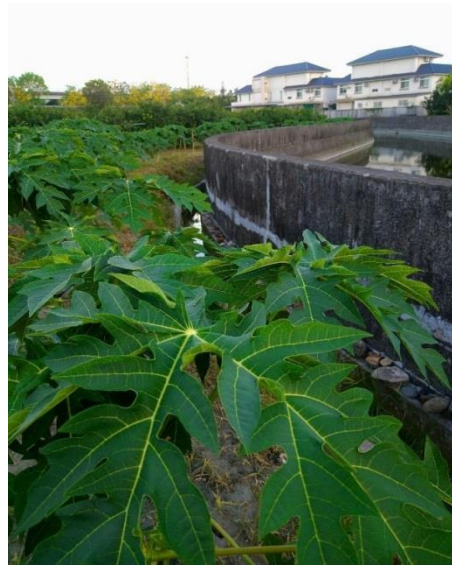
若田區排水不易，應用抽水工具協助排水。
