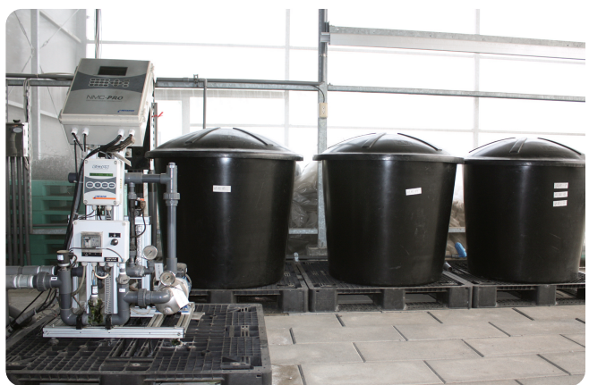
圖10. 自動化肥灌設備主機及肥料桶
