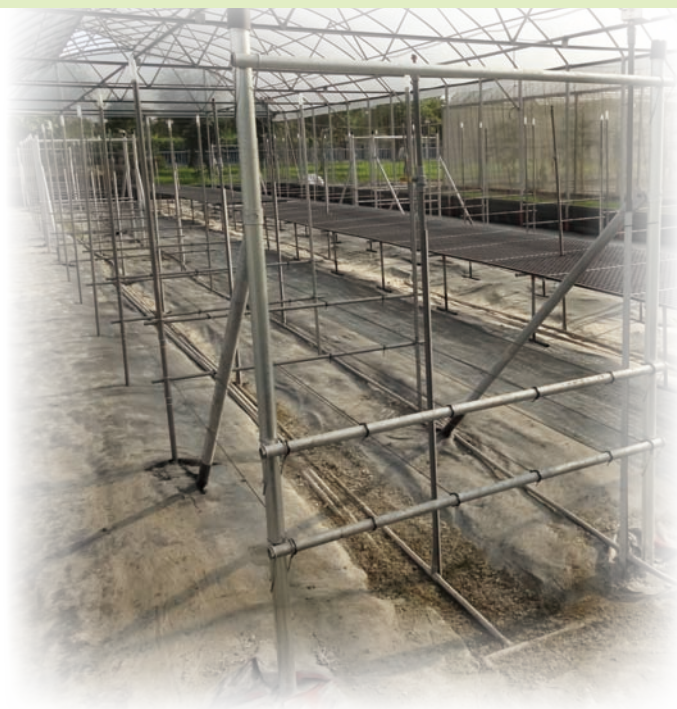
圖7. 固定支架的搭設
