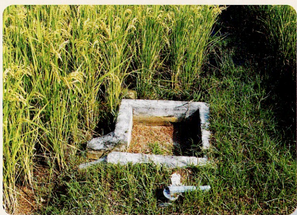
以地下暗管實施灌溉，確保水質及防治福壽螺
