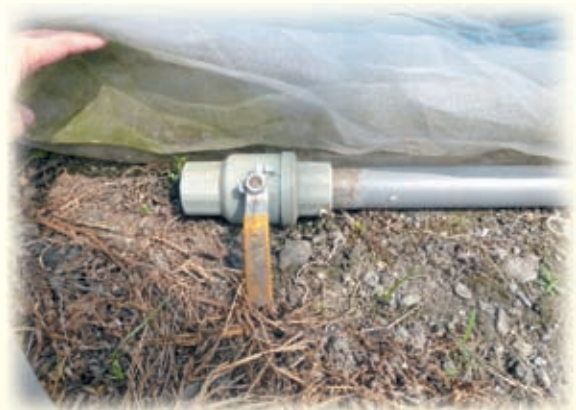
▲圖10.供水管路末端必須可以排水。
