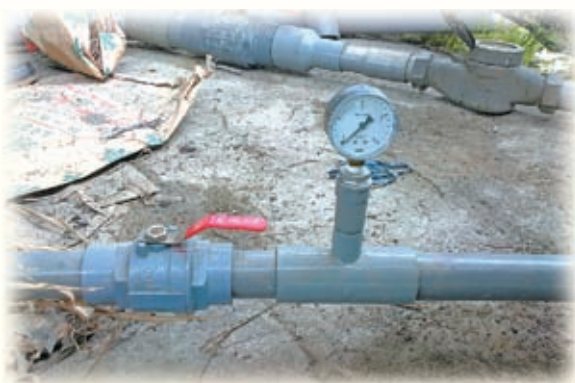
▲圖7.在木瓜田區供水端裝設壓力表，並將壓力調節在 1.5 公斤，有助於田區滴灌管壓力管理。
