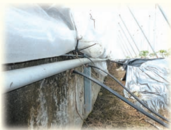
▲圖9.田區供水管配置以不影響作業道、裸露為原則。
