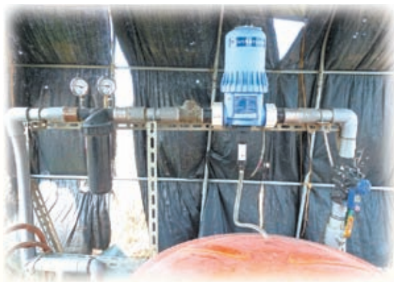
▲圖4.高雄區農業改良場所使用的定比稀釋器(藍色機體)。
