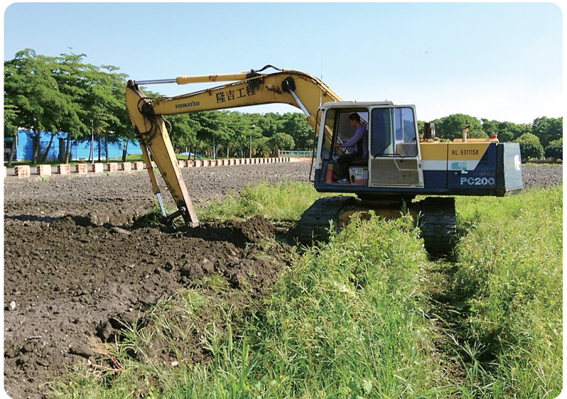
圖6. 200型挖土機整地作業情形
