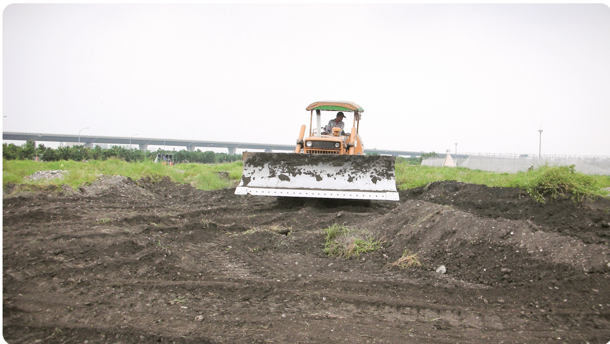
圖5. 利用大型推土機將土地整平
