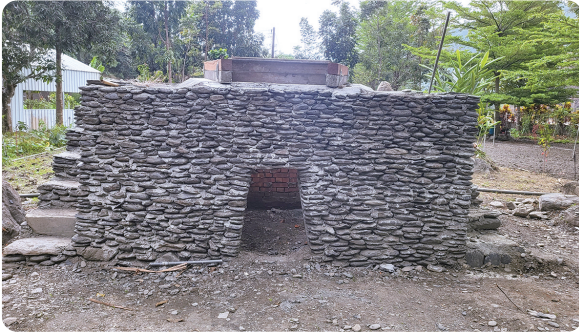
圖2. 烤窯外圍以石板或石塊砌成方形構造
