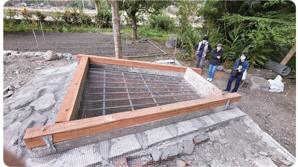
圖3. 烤棚架為倒梯形現多改鐵絲網搭造，前窄後寬、前低後高。
