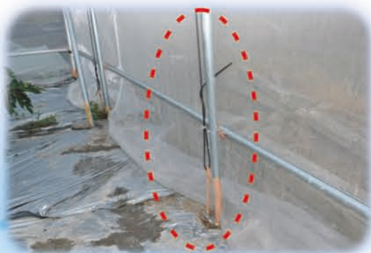
網室內以深埋1.2公尺的T型地牛接鋼索固定
