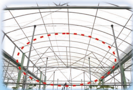
構造梁上做“力霸型牽引補強”(紅色圈)
