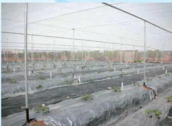
圖1. 高雄場所搭設之結構加強型木瓜網室
