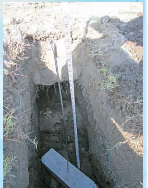
圖3. 結構加強型木瓜網室所使用之地錨
