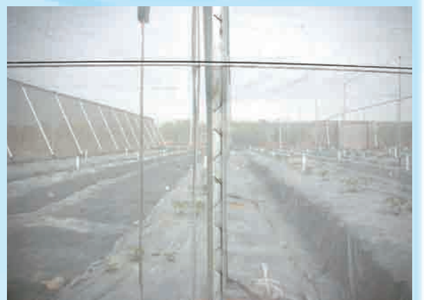
圖4. 以固定壓條及塑鋼繩固定塑膠網
