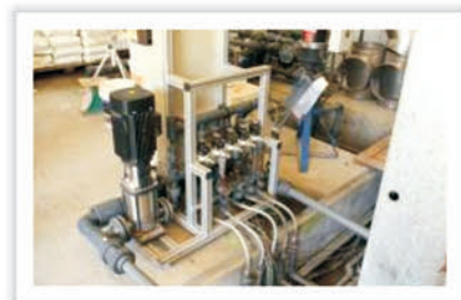
肥灌系統控制主機與肥料混合機構
