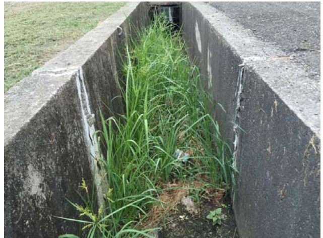
檢查排水溝，將雜草及垃圾清除避免堵塞
